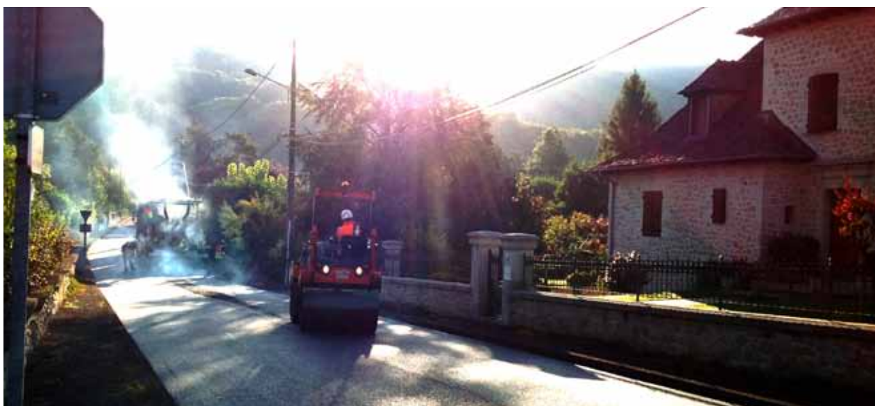
Réfection de la chaussée rue André Malraux
