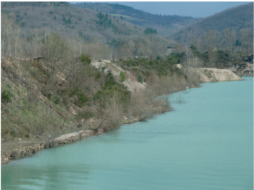
Terrasse réalisée en bas de digue
