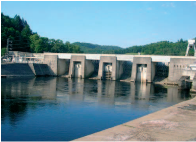
Barrage du sablier
